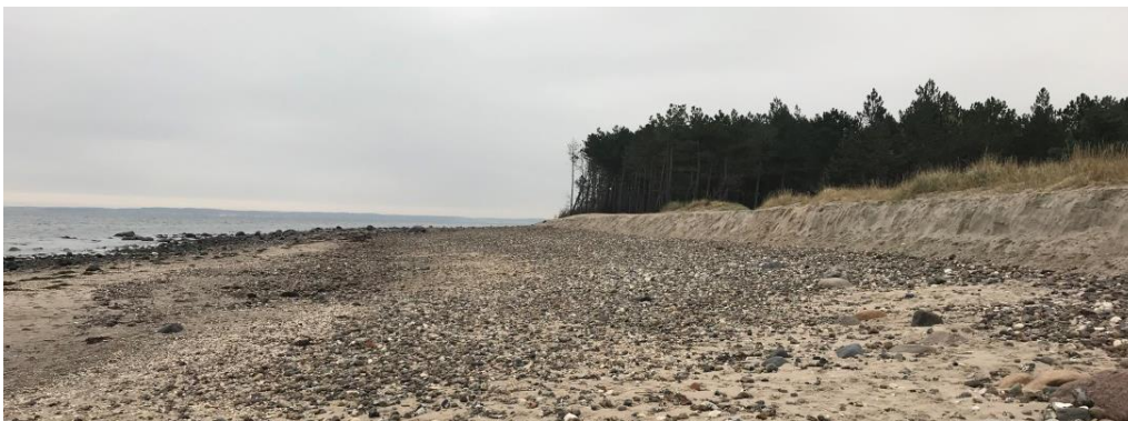
Figur 3.30 Ubeskyttet erosionskyst i den vestlige del af Hornbæk Plantage (St. 46,1-48,6). Bemærk erosionskant i strandfodringsmateriale efter stormen Ingolf 28. oktober 2017. Fotoet er taget d. 08-11-2017.
