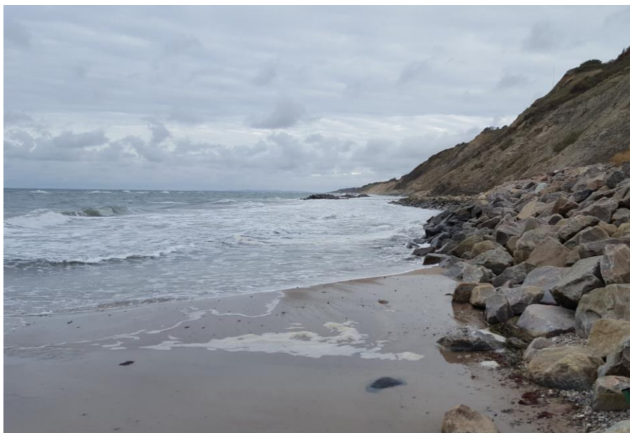
Figur 2.1 Stejl og høj skråning ved Salgårdshøj med lav skråningsbeskyttelse, der beskytter mod erosion og dermed hindrer tilførsel af materiale til stranden, som er forsvundet foran skråningsbeskyttelsen. Fotoet er taget d. 31-10-2017 af NIRAS.
