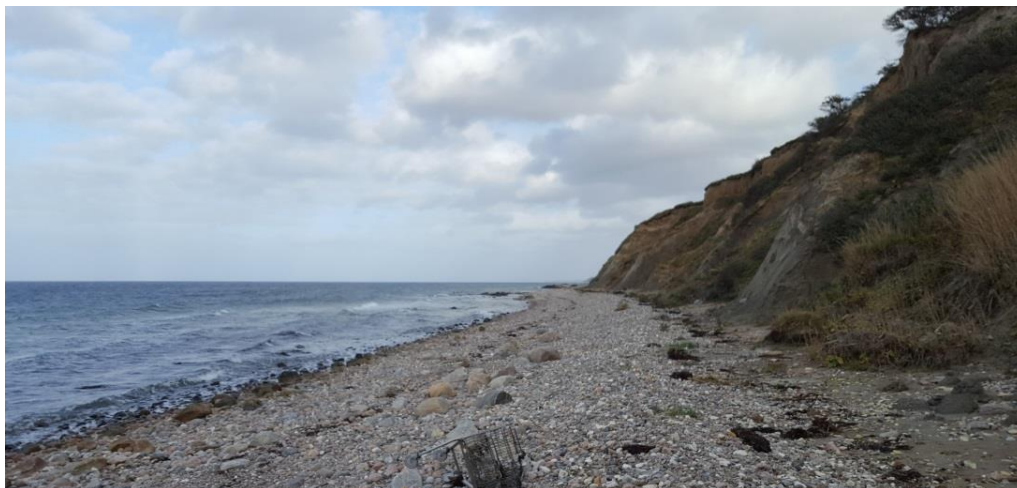
Figur 3.10 Ubeskyttet strækning med aktiv skrænterosion, Spodsbjerg Øst (St. 1,4-1,9). Fotoet er taget d. 17-10-2017.
