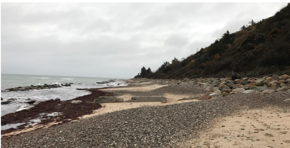
Figur 3.23 Gilleleje Strand beskyttet med skråningsbeskyttelse og bølgebrydere (St. 33,0- 35,2). Fotoet er taget d. 01-11-2017.
