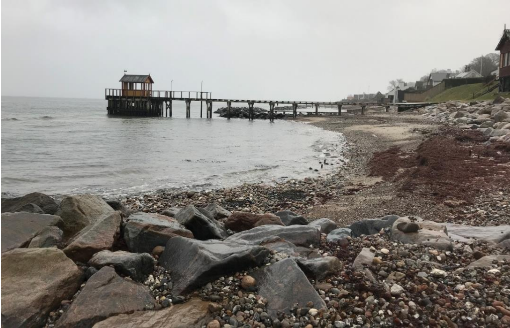
Figur 3.31 Kyststrækning ved Ålgårde beskyttet med skråningsbeskyttelse, bølgebrydere og høfder (St. 49,5-50,5). Fotoet er taget d. 14-11-2017.
