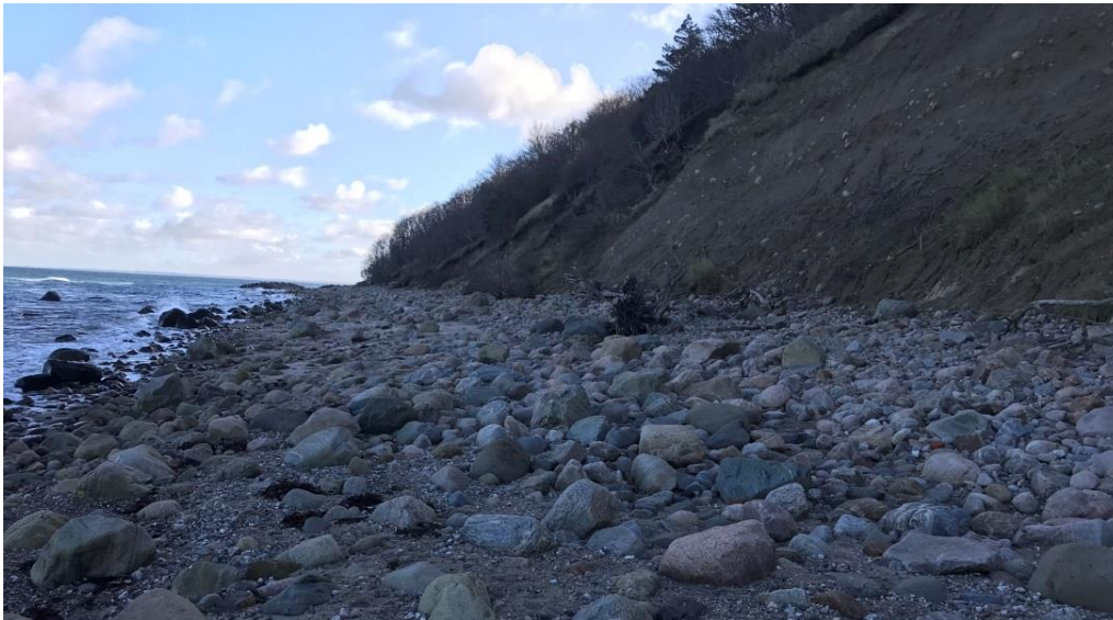
Figur 3.24 Generelt ubeskyttet kyststrækning med aktiv skrænterosion ved Nakkehoved (St. 37,4-39,6). Fotoet er taget d. 06-11-2017.
