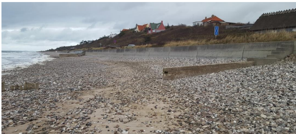
Figur 3.18 Rågeleje Strandvej beskyttet mod erosion af betonmur (St. 24,9-26,4). Fotoet er taget d. 31-10-2017.
