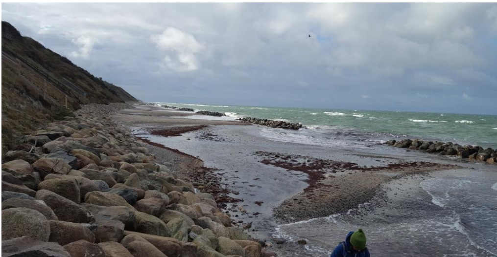
Figur 3.17 Kyststrækning med skråningsbeskyttelse og erosion bag bølgebrydere ved Vejby Strand (St. 17,4-22,8). Fotoet er taget d. 31-10-2017.
