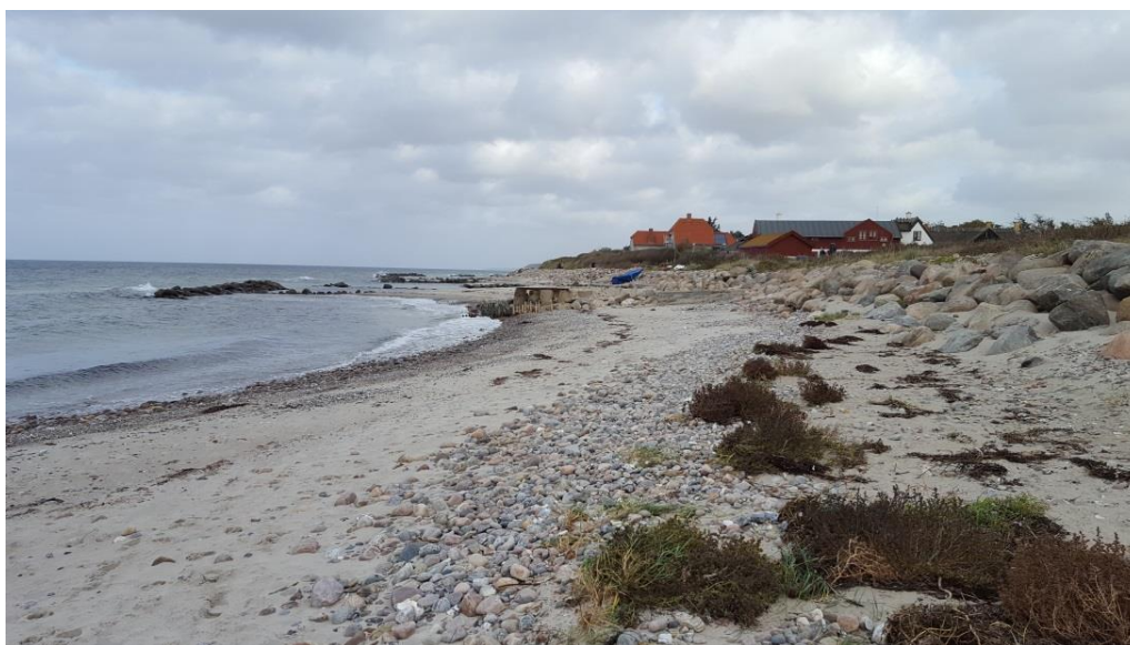
Figur 3.11 Kikhavn beskyttet med bølgebrydere og skråningsbeskyttelse (St. 1,9-3,3). Fotoet er taget d. 17-10-2017.
