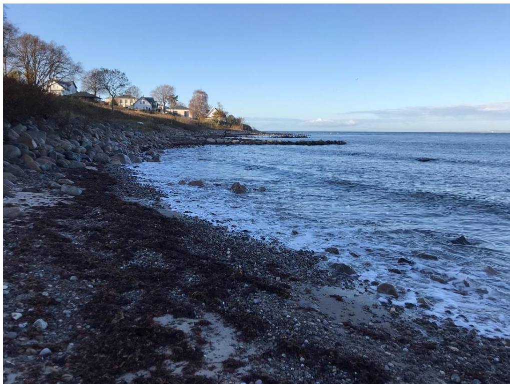
Figur 3.33 Kyststrækning præget af skråningsbeskyttelser og hølfer ved Hellebæk (St. 53,2-54,2). Fotoet er taget d. 15-11-2017.
