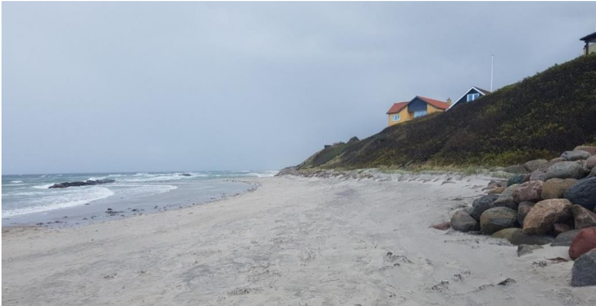
Figur 4.4 Bølgebrydere ved Liseleje.
